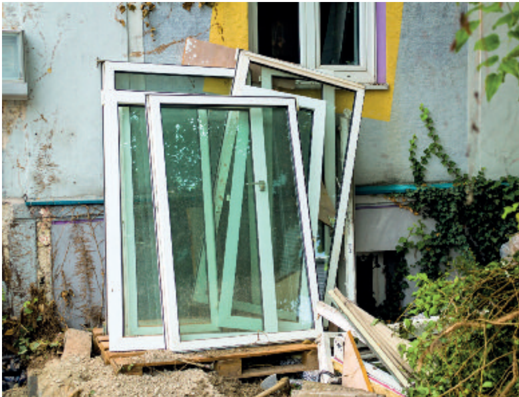
Bei den betroffenen Häusern sollen unter anderem die Fenster ausgetauscht werden
